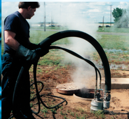
Откачка жидкости из канализационных люков
