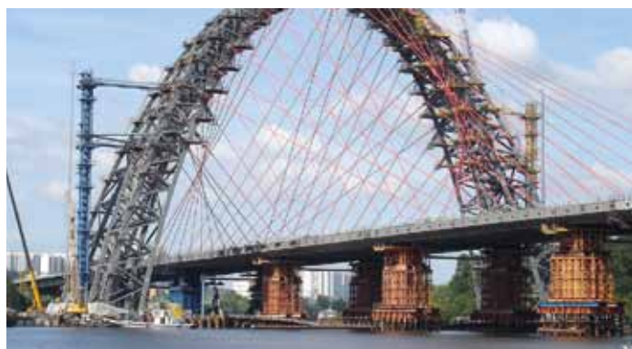
Крепление ограждающих конструкций правобережной эстакады ванто-пилонного моста (г. Москва, 2007 г.)
