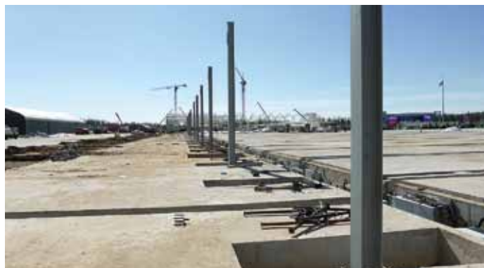
Монтаж колонн здания учебно-демонстрационного центра. Протяженность по фасаду 1560 метров (Военно-патриотический парк культуры и отдыха Вооруженных сил РФ «Патриот», Московская область, г. Кубинка, 2016 г.)
