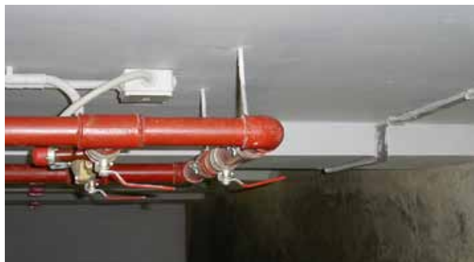
Монтаж трубопроводов высокого давления sprinklerной системы пожаротушения к пустотелым плитам межэтажных перекрытий с применением сетчатых гильз
