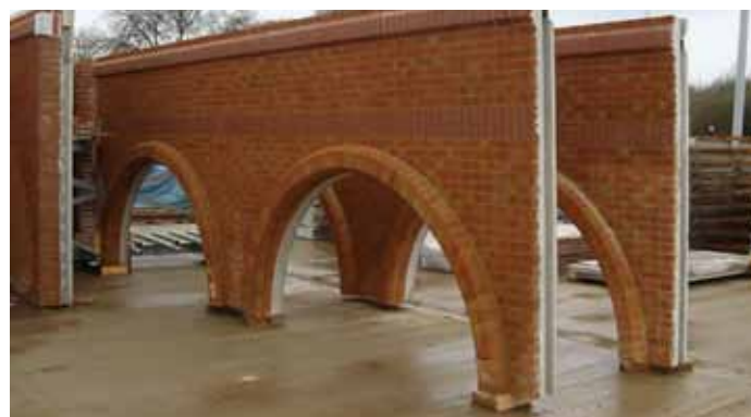
Наклейка клинкерной и фасадной керамической плитки на готовые стеновые панели
