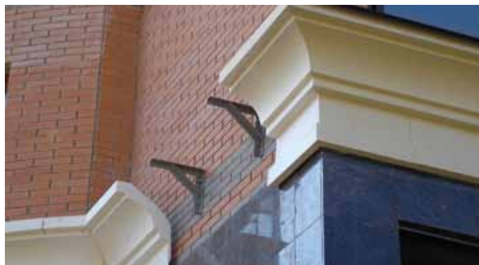
Крепление элементов архитектурного декора к облицовке из пустотелого кирпича (применение металлических сетчатых гильз для обеспечения требуемой степени надежности)
