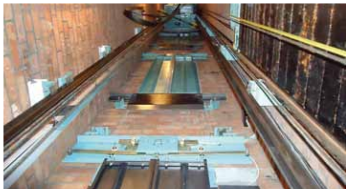
Монтаж лифтового оборудования, кронштейнов направляющих и механизмов порталов к стенам лифтовых шахт, выполненных из кладочных материалов и пустотелого кирпича
