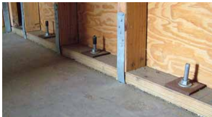
Установка анкерных и фундаментных болтов
