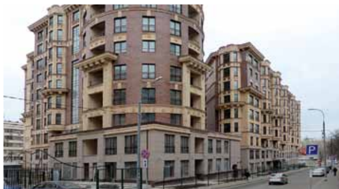
Облицовка фасада архитектурными элементами, выполненными из стеклофибробетона. Площадь фасада 10 000 м². (Многофункциональное здание, Москва, 2012 г.)
