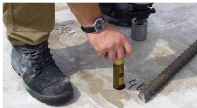
Установка капсулы для монтажа арматуры периодического профиля
