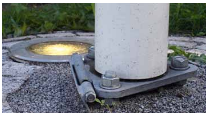
Крепление металлического флажстока к основанию из природного камня
