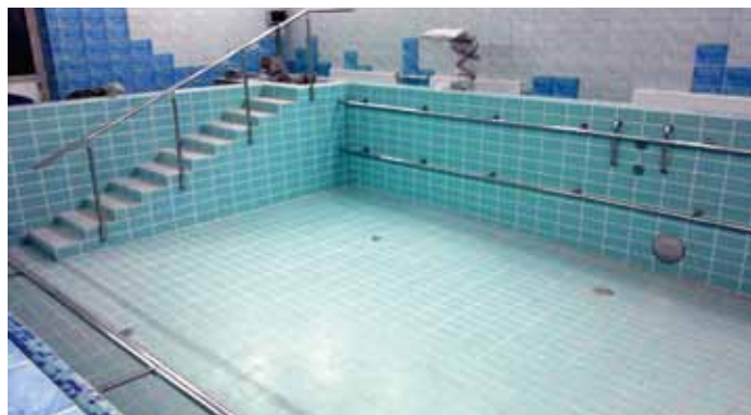
Монтаж поручней из нержавеющей стали в плавательном бассейне (высокие требования к коррозионной устойчивости при долговременном воздействии хлорированной воды)
