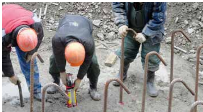
Устройство арматурных выпусков в существующей фундаментной плите (технологический регламент: очистка отверстий, инъецирование, установка арматурных стержней)
