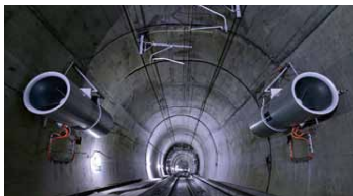
Крепление вентиляционного и технологического оборудования в тоннелях (высокие эксплуатационные нагрузки, большие диаметры анкеров, растянутая зона бетона)
