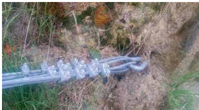
Узел крепления оттяжки кольцужной сетки динамического противокамнепадного заграждения энергоемкостью 500 кДж непосредственно в горную породу (глубина заделки анкера 1500 мм)
