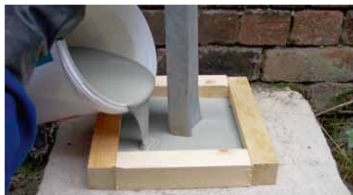
Высокоточная подливка оснований фундаментов
