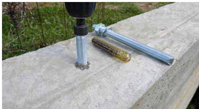
Установка анкер-шпилек ВІТ-SS 16 × 190 с торцевым шестигранником в бетонный ленточный фундамент (применение специального адаптера для перфоратора)
