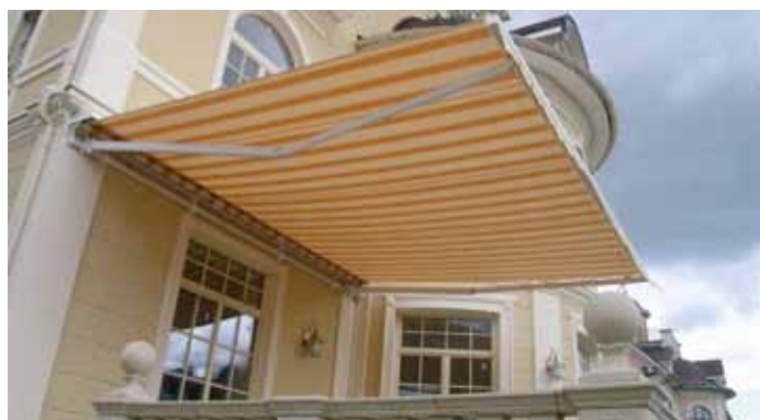
Крепление конструкций и механизмов выдвижной маркизы к зданию исторической застройки (высокие ветровые нагрузки)
