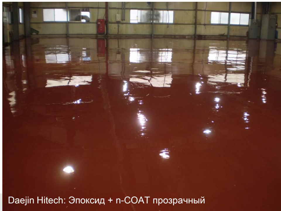
Фабрика Daedong Cheonbuk: Тонкослойный эпоксид + n-COAT прозрачный
