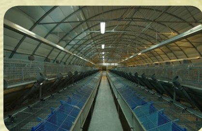
Здание внутри 45 x 9,3 м
