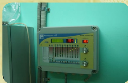
Станция управления микроклиматом
