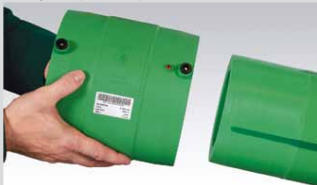
Насаживание электромуфты на зачищенный край трубы
