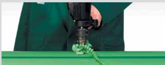
Просверливание отверстия в стенке трубы
