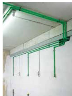
Монтаж на штукатурку
