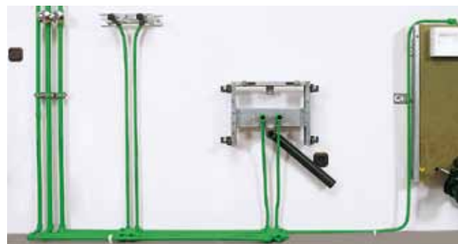
Монтаж на стене
