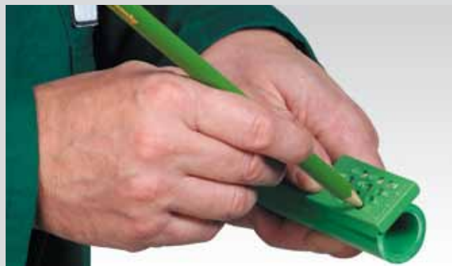
Отметка глубины сварки
