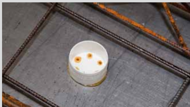
Нижняя часть спринклерного соединительного элемента арт. № 4114190 для скрытого спринклера. Крепление горячим клеем.
