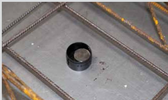
Нижняя часть спринклерного соединительного элемента арт. № 4114180 для видимого спринклера. Крепление магнитом.
