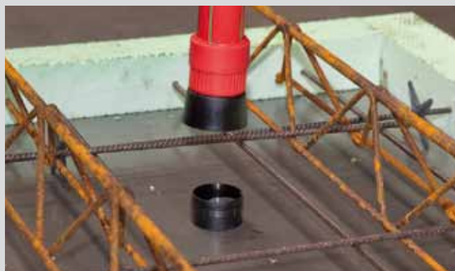
Верхняя часть спринклерного соединительного элемента с отрезком трубы и переходником вставляется в нижнюю часть спринклерного соединительного элемента.
