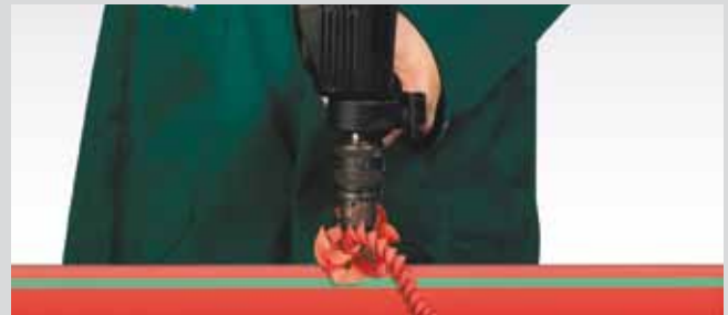
Просварливание отверстия в стенке трубы.
