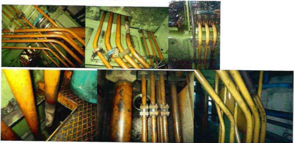
№2. Трубопровод --от главных насосов Main Pump №1-2-3 до блока ИТЕМ №1. Участок из приемка подъём на гидробак.
