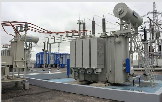
Антикоррозионная окраска металлоконструкций на объектах «ФСК ЕЭС»
