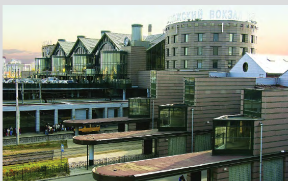
Окраска металлоконструкций Ладужского вокзала в г. Санкт-Петербург
