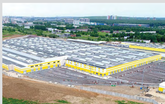
Окраска металлоконструкций в электродепо «Солнцево»
