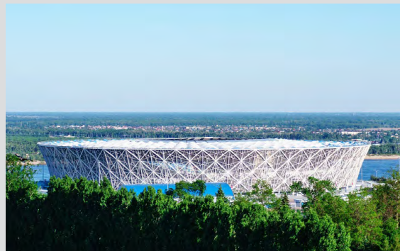
Антикоррозионная окраска трубопроводов стадиона «Волгоград Арена»
