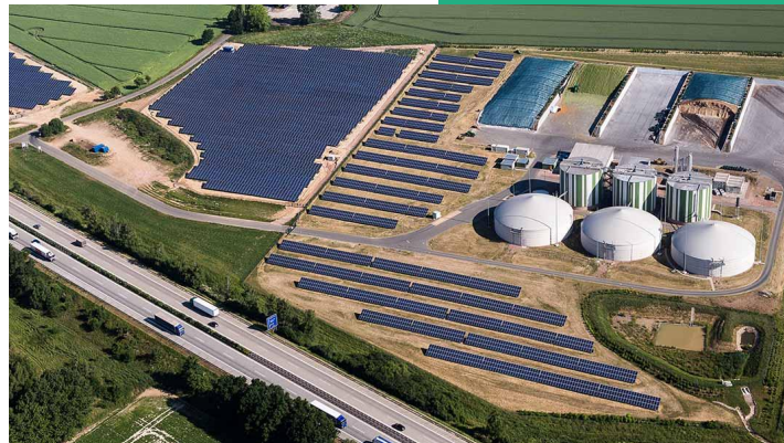
Biogasanlage Haßlau, Leistung: 994,75 kWp
