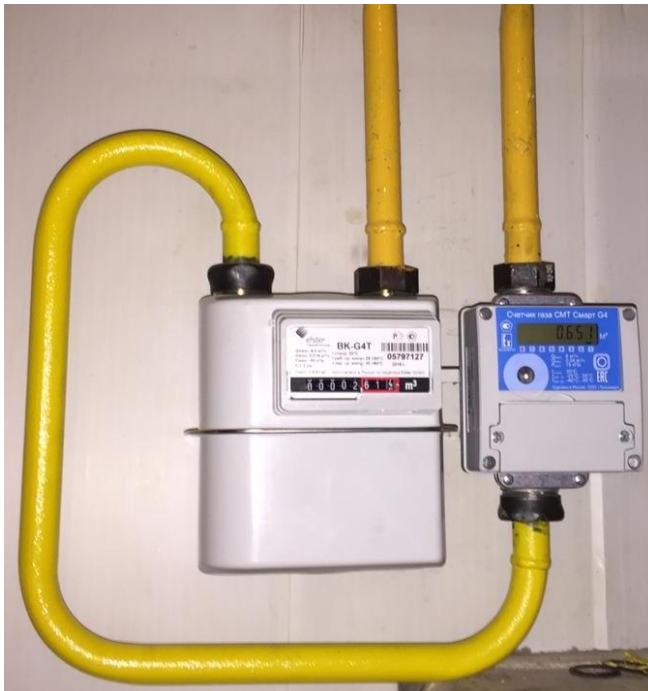
Опытная эксплуатация СМТ-Смарт. Установка счетчика Нижегородская область, г.Арзамас, ул.Октябрьская д.17
