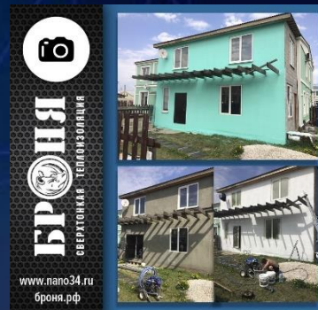
Броня Стена при теплоизоляции фасада жилого дома Тольятти Самарской области
