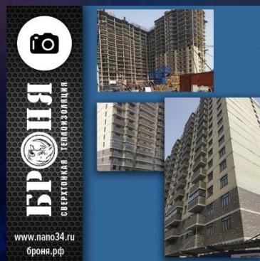
Применение Броня Стена при строительстве жилого комплекса Сокол на Оганова г.Ростов-на-Дону
