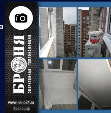
Броня Фасад и Броня Акваблок при утеплении балкона и части фасада квартиры многоэтажного дома. г. Санкт-Петербург
