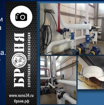
Применение Броня классик для теплоизоляции рекуператоров и паропроводов мебельной фабрики "Сургутмебель". Сургут.
