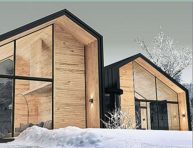
Наружная отделка зданий
