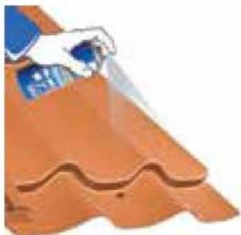
Места срезов и повреждений полимерного покрытия необходимо обрабатывать специальной ремонтной эмалью
